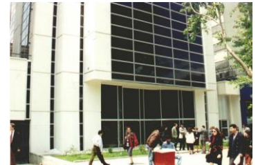
Shell Vakfı giriş cephesi
